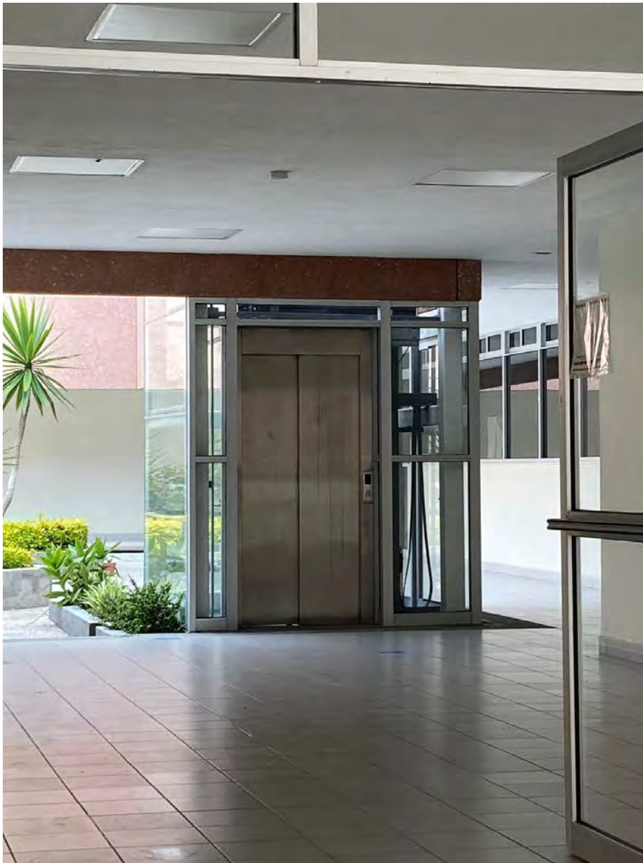
Figura 53. Elevador ubicado en el Edificio de Gobierno que conecta con los edificios 1 y 2 de la UPIITA.
